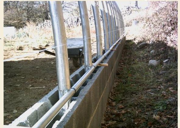
Le tunnel est maintenu par des tubes ronds  $\varnothing 50\text{mm}$  (fournis) passés dans un fourreau de chaque côté, avec échancrures pour passage des tendeurs à cliquet. Anneaux de vache et chevilles à expansion pour fixation sur le muret.
