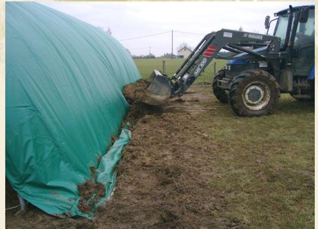
Le tunnel est posé sur la terre et est maintenu par 1.5m de bâche enterrée dans des tranchées à l'extérieur du tunnel.
