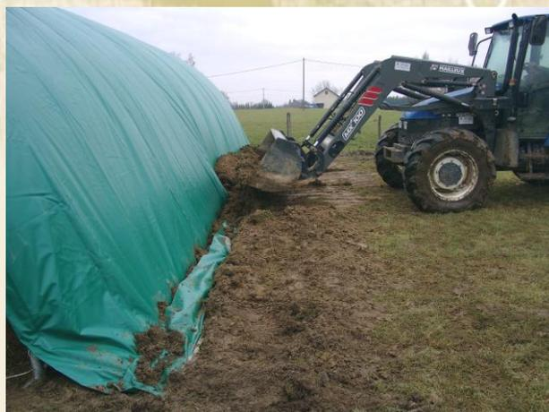
Le tunnel est posé sur la terre et est maintenu par 1.5m de bâche enterrée dans des tranchées à l'extérieur du tunnel.
