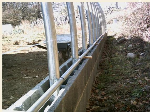
Le tunnel est maintenu par des tubes ronds Ø50mm (fournis) passés dans un fourreau de chaque côté, avec échancrures pour passage des tendeurs à cliquet. Anneaux de vache et chevilles à expansion pour fixation sur le muret.
